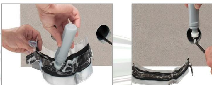
5. Wickeln Sie den OKT - Beutel um das Kabel, überlappen Sie die beiden Klebeseiten und richten Sie ihn im Kabelkanal (bündig zur Stirnfläche) aus
