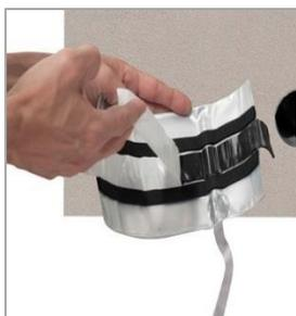
4. Tragen Sie das beiliegende Schmiermittel auf beide Seiten des OKT-Beutels und dem Kabelmantel auf
